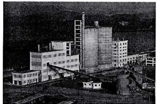
Nhà máy Xi măng Yên Bình
