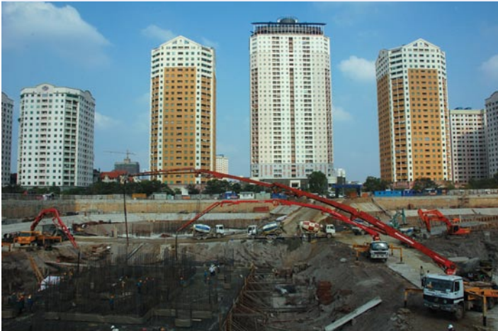
Công trường thi công Dự án N05
